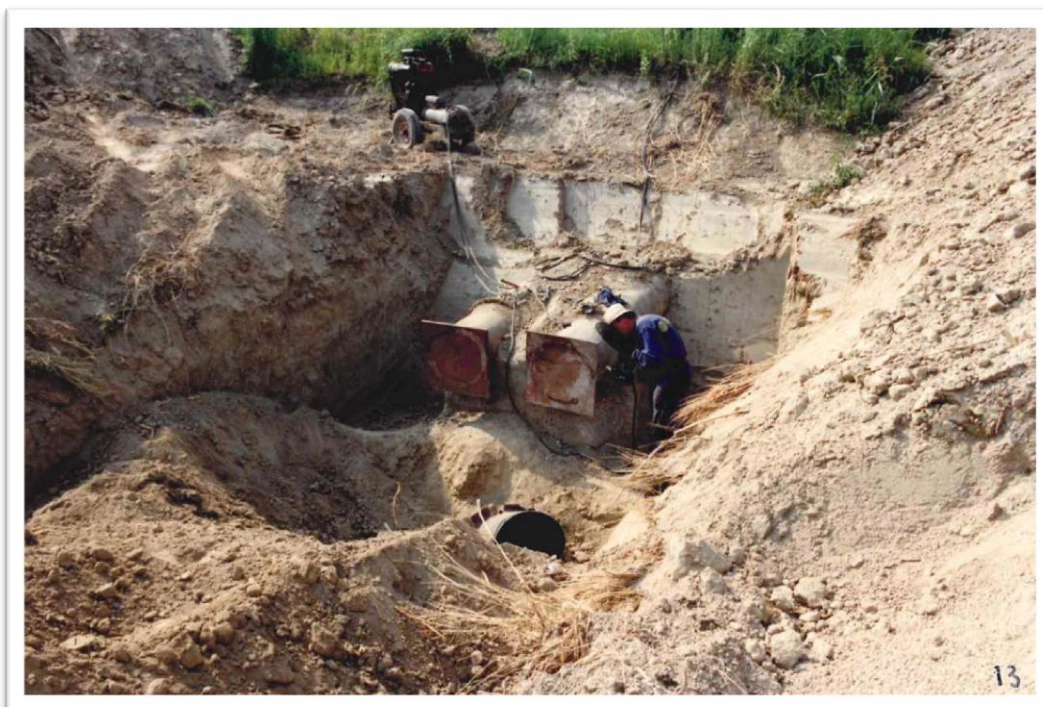
Foto 5 – vista di repertorio delle tubazioni da demolire
